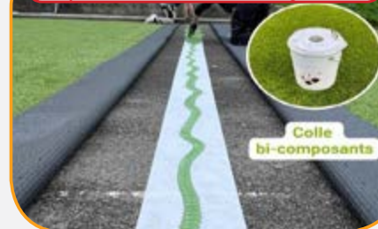
Colle PU bicomposant : Adhérence ultra-résistante pour une fixation durable de vos gazon
